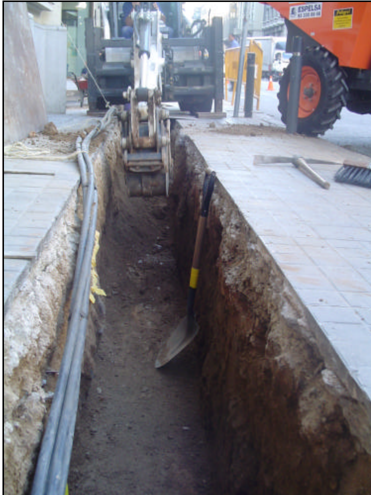
Foto 1: Treballs de l'obertura de la rasa a la Via Laietana.
