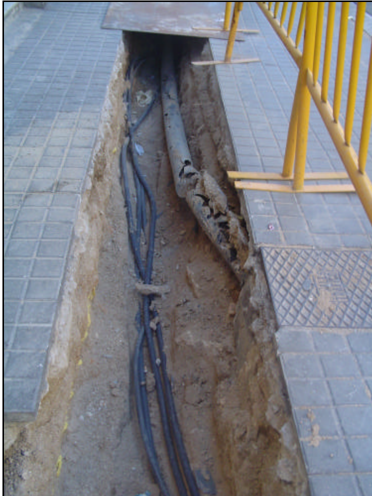
Foto 2: Rebaix efectuat a La Via Laietana 57.
